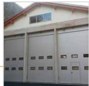
Die Tore der Serie ISD kann man mit einer Schlupftür liefern und somit kann man einen zusätzlichen Eingang in den Raum ohne die Notwendigkeit das ganze Tor zu öffnen sichern. Für die Erhaltung der Luftundurchlässigkeit und der Wärmedämmung ist am Umfang der integrierten Tür eine doppelte Dichtung verwendet.
