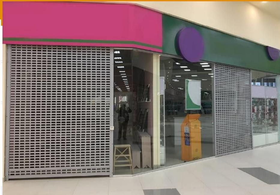
Teilverglasung: Torblatt kombiniert mit Lichtlamellen, die mit Polycarbonat-Scheiben gefüllt sind.
